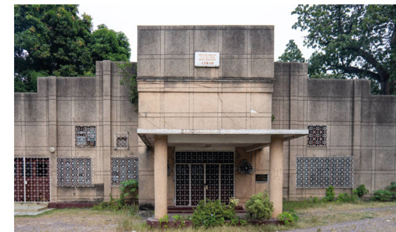
Façade du CFRAD, 2024 - CC
