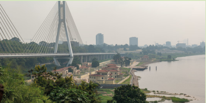
Pont du 15 août 1960, 2024 - CC
